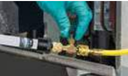
Inyecte en conductos con refrigerante
