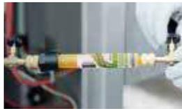
Inyecte en conductos con refrigerante
