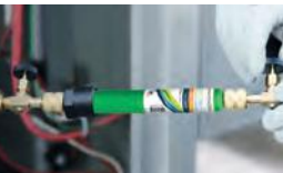
Befüllung mit dem Kältemittel
