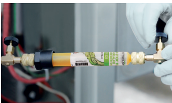
Befüllung mit dem Kältemittel
