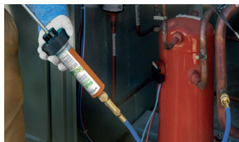
Injektion des Färbemittels durch Drehen des Griffs.
