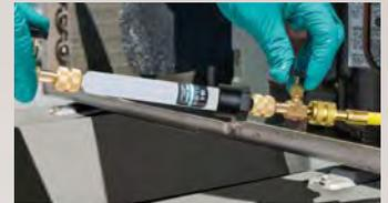
Befüllung mit dem Kältemittel
