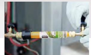
Befüllung mit dem Kältemittel
