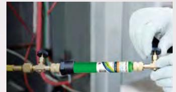
Befüllung mit dem Kältemittel
