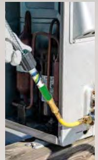
Injektion des Färbemittels durch Drehen des Griffs.
