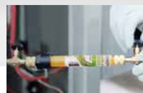
Charge en ligne avec le réfrigérant
