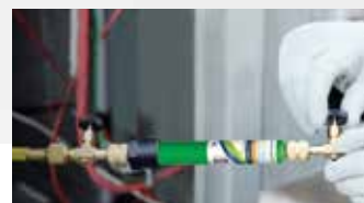
Charge en ligne avec le réfrigérant
