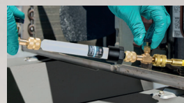
Befüllung mit dem Kältemittel
