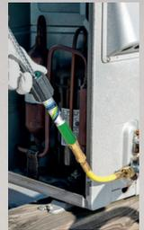
Injektion des Färbemittels durch Drehen des Griffs.
